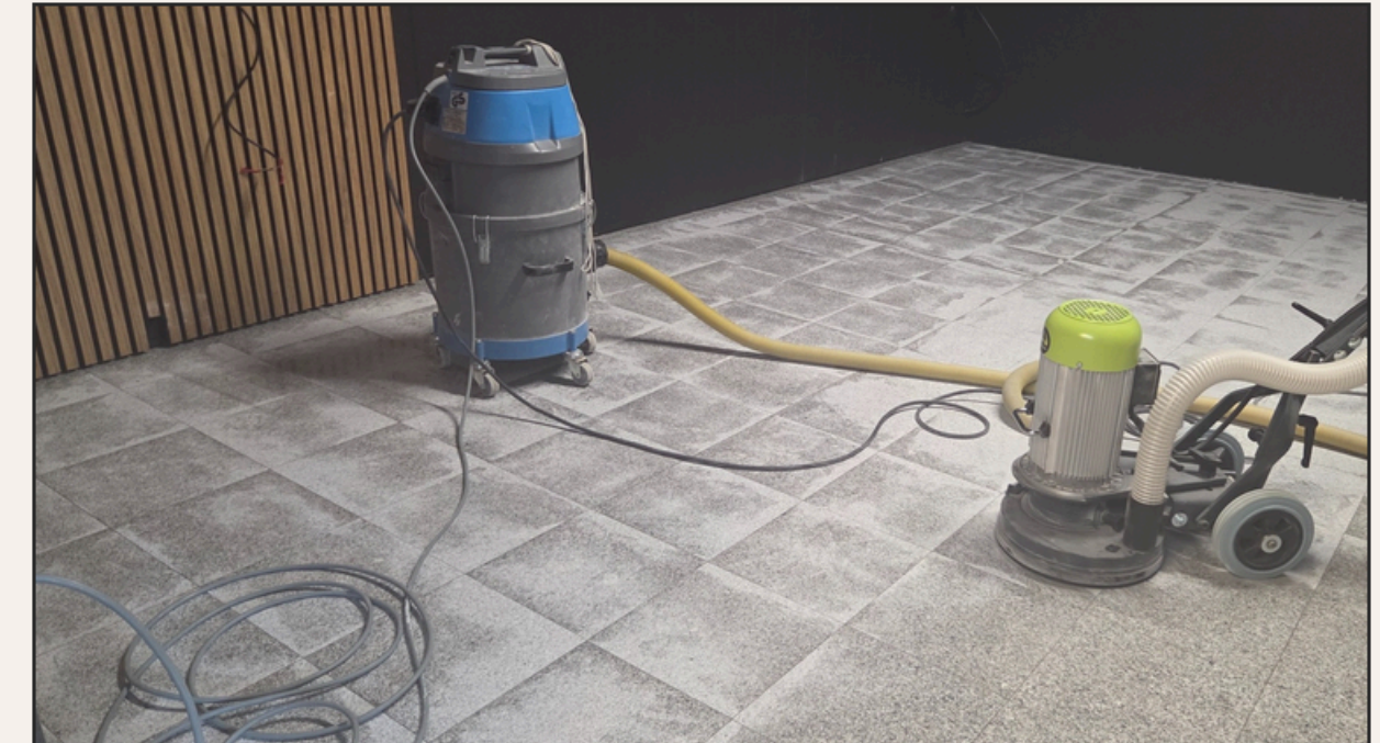
Radovi u izvedbi tijekom postavljanja specijalnog poda.
